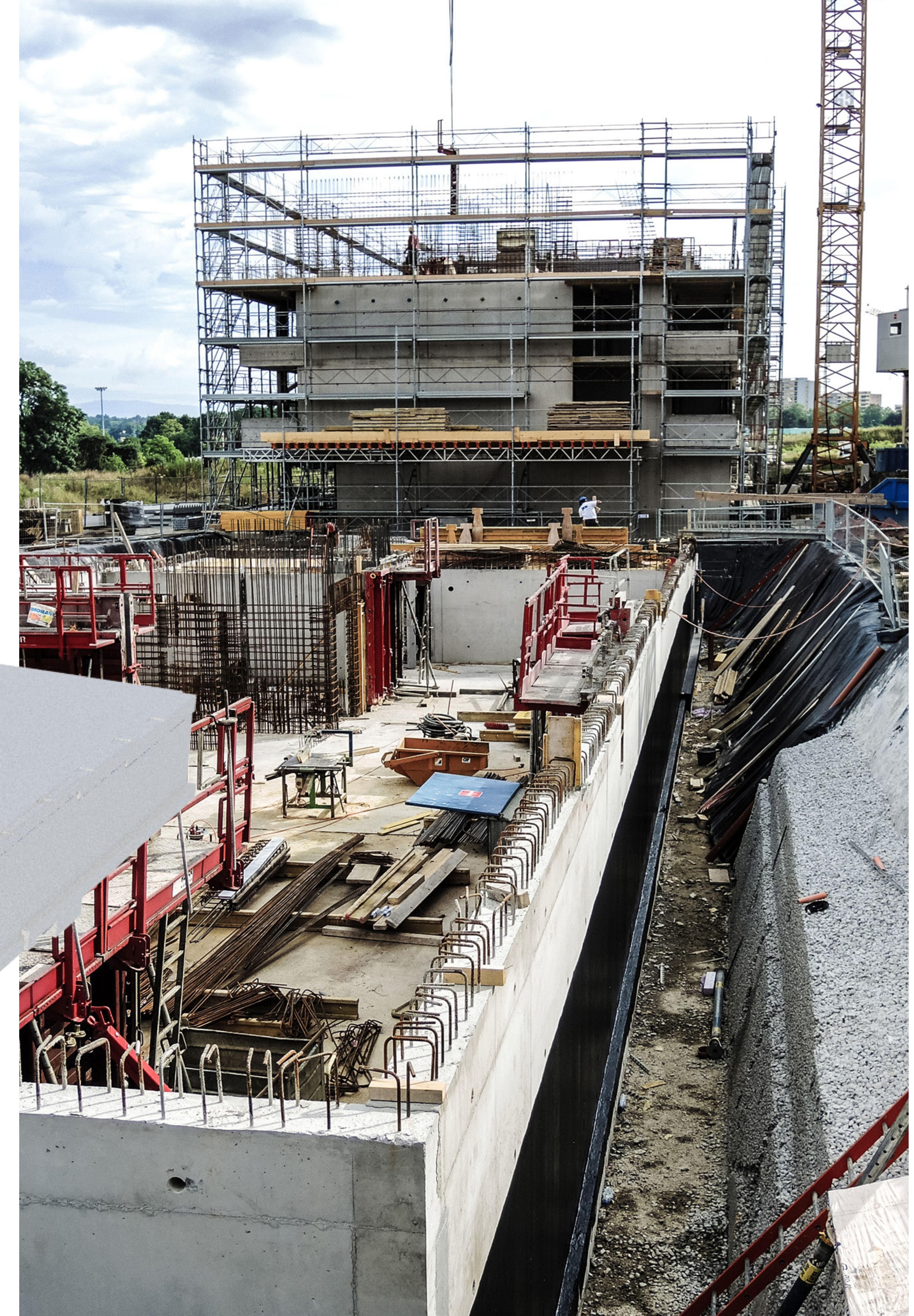
Cage d'escalier en béton armé
