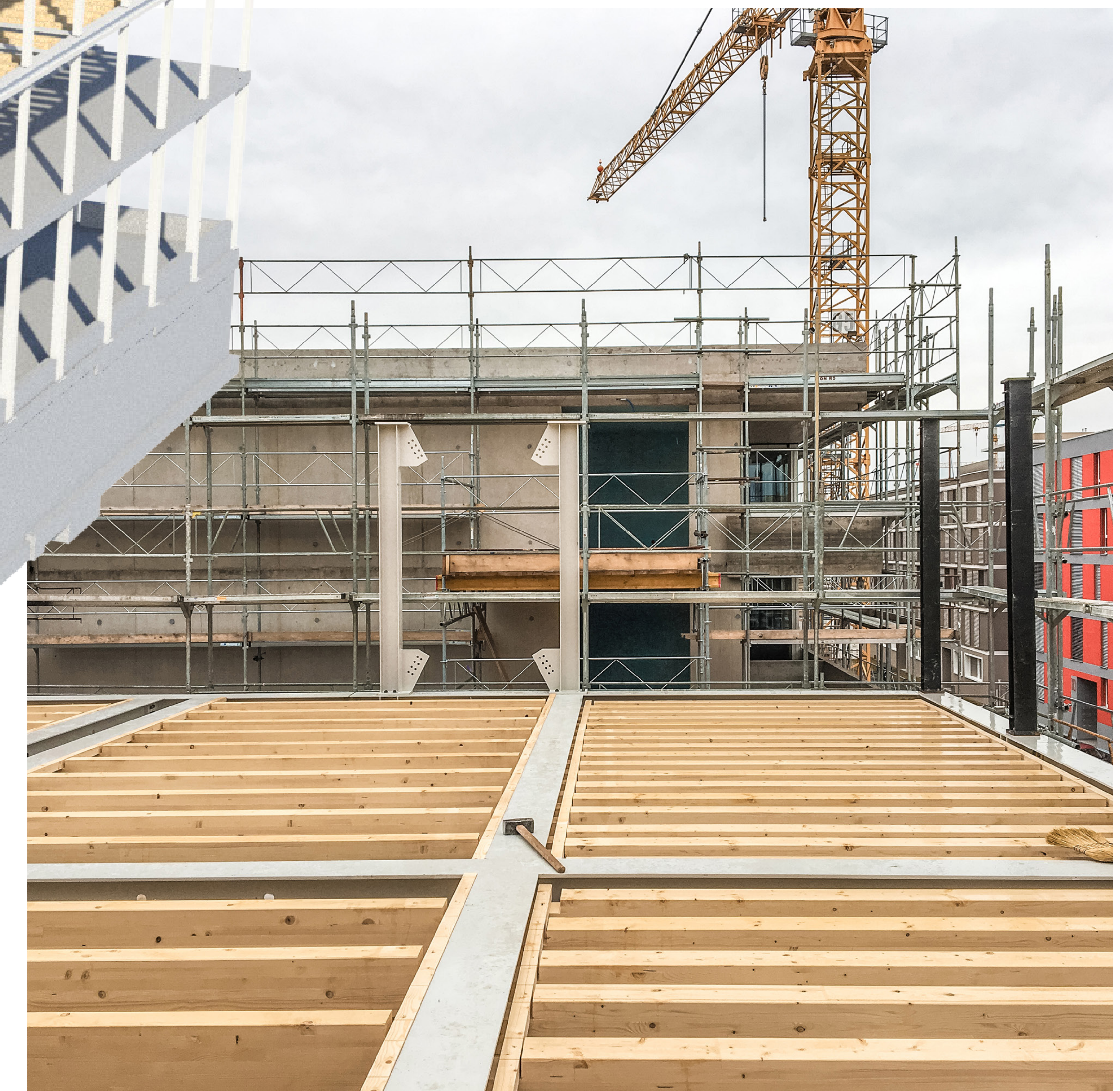
Structure secondaire, composée de solives en bois lamellé-collé (BLC)
